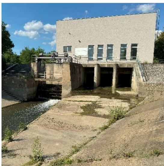
Výpustný objekt poldru Soutok
