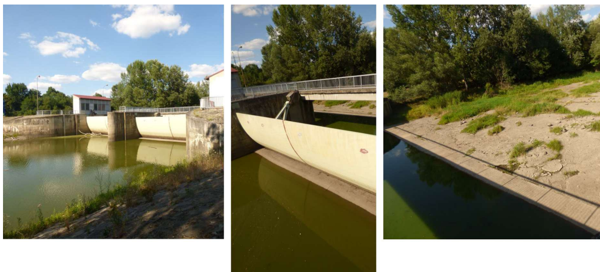
Obr. 29: Jez Pohansko, celkový pohled, detail dosedacího prahu, ze jezem
